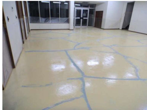
クラックを補修し1回目を塗装
