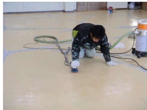
1回目を塗装後、旧塗膜を更に研磨
