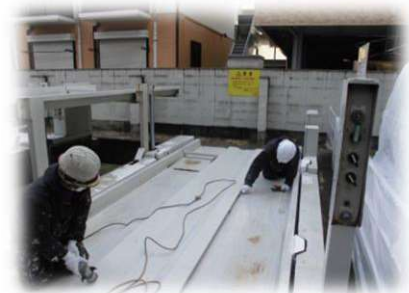
オフィスとマンションが密接する箇所の為騒音の出る機械が使えず、手作業でケレン
